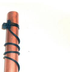
4) Enrole o cabo elétrico duas voltas ao redor da tubulação;
