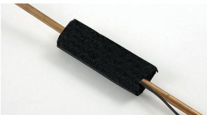
4) Enrole o cabo elétrico na base do sensor duas voltas ao redor da tubulação;
