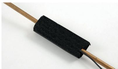
5) Cubra o sensor com isolamento térmico de pelo menos 10 cm nas extremidades da tampa e do cabo enrolado;
